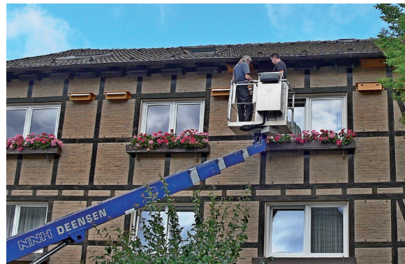
Foto: Markus Janz (links) und NNH-Mitarbeiter Andreas Görte beim Anschrauben der Sicherungsbleche an die Mauerseglerkästen (T. Frischgesell)
