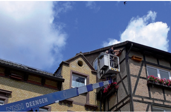
Foto: Markus Janz und NNH-Mitarbeiter Andreas Görte (vorn) beim Anbringen neuer Mauerseglerkästen (T. Frischgesell)
