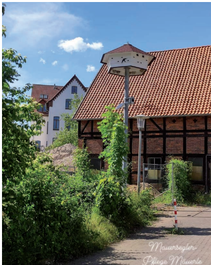
Foto: Fertig gestellter Nistturm (R. Kubal)
