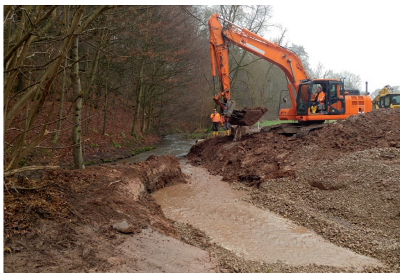
Foto: Nach dem Durchstich fließt erstmals Wasser in das neue Bachbett (S. Beyer)
