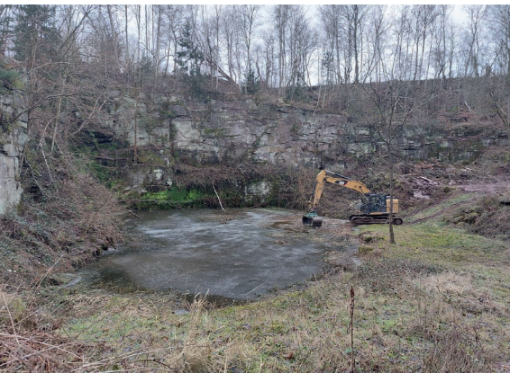
Foto: Baggereinsatz am Gewässer (K. Fasse)
