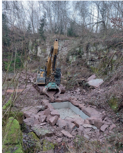
Foto: Einbau eines Betonbeckens (K. Fasse)
